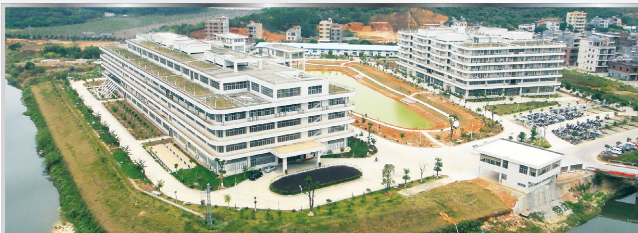
中國湖鎮東風村廠房及宿舍大樓
